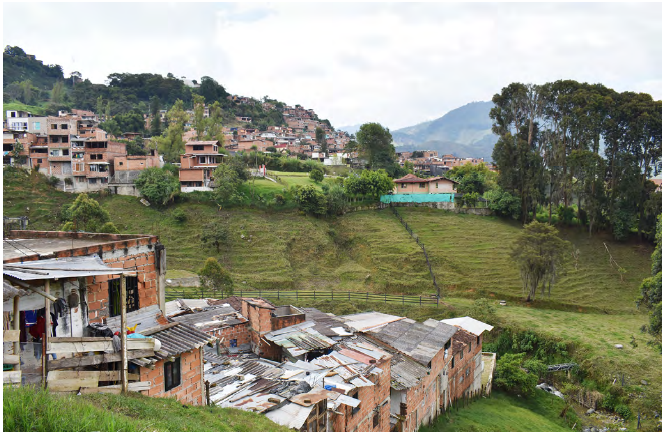
Die einfach gebauten Häuser stehen oft an gefährdeten Hanglagen.
